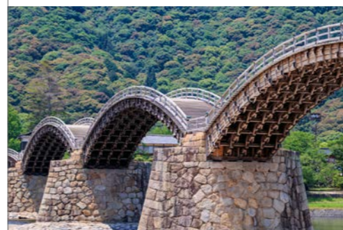
伝統技術の粋を集めた錦帯橋
